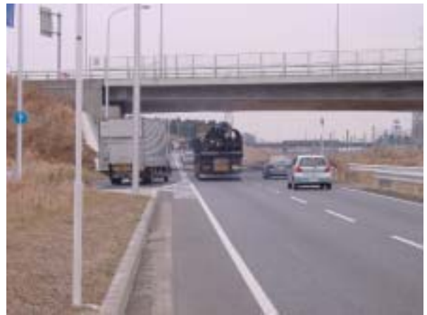
写真 - 1 区間 7 施設出入口
